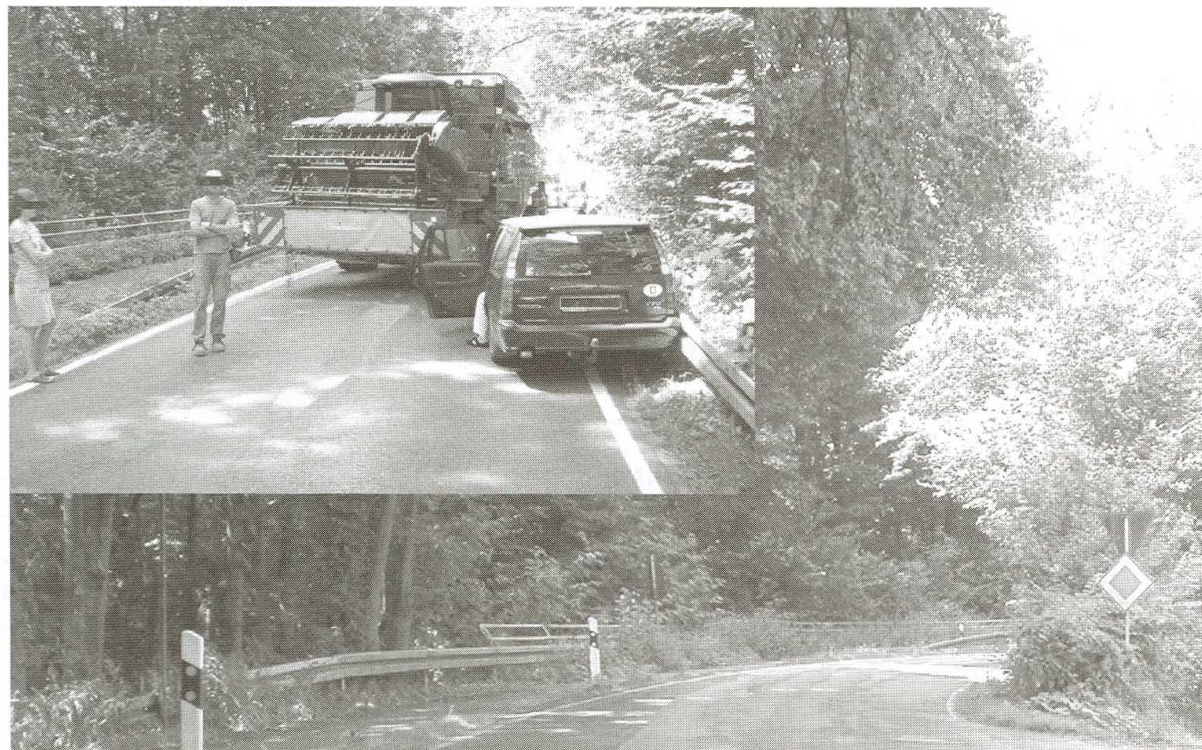
Abb. 4: Sichtbehinderung durch Bewuchs
