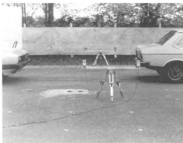
Position der 1. Lichtschranke
